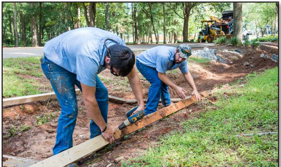
Avondale Subdivision culvert work
