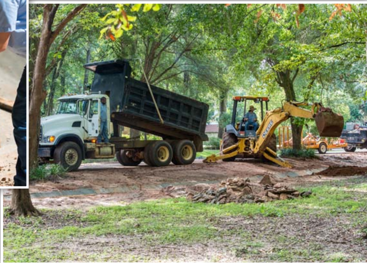
Avondale Subdivision culvert work
